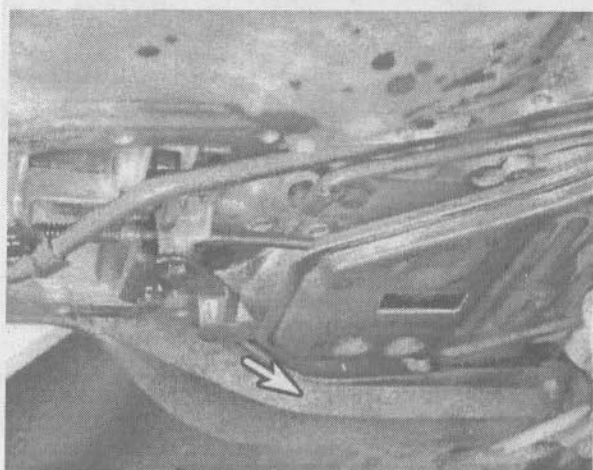
27.10а. Выверните фильтр из зажима на коробке передач (указан стрелкой), затем вытащите вниз и снимите его
